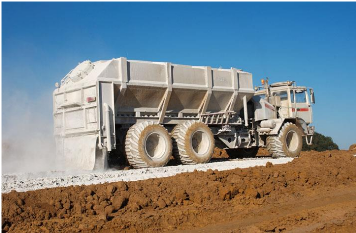
photo DTP Terrassement
