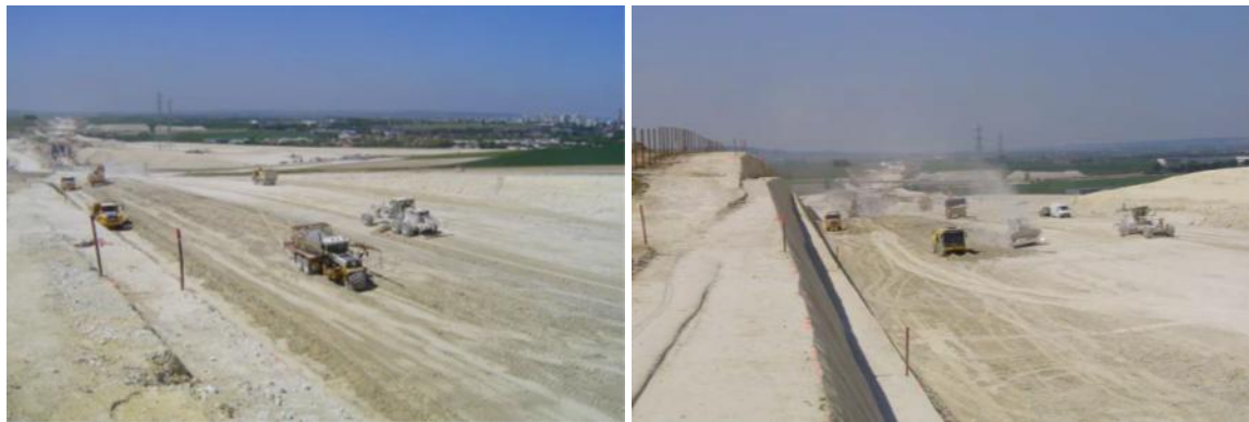
Illustrations : Reprise de la passe de matériau traité / Traitement dans le déblai
