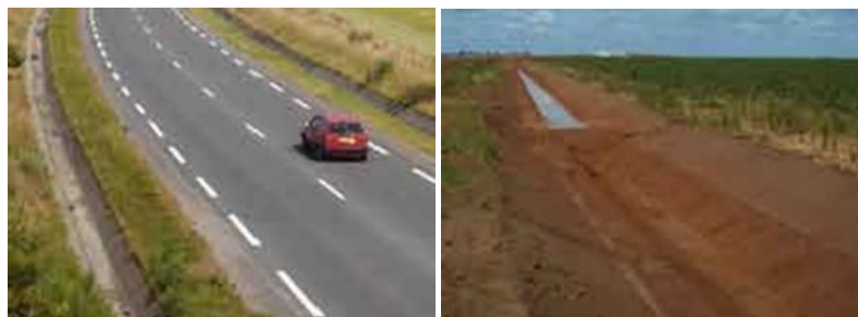
Assainissement en phase de construction
