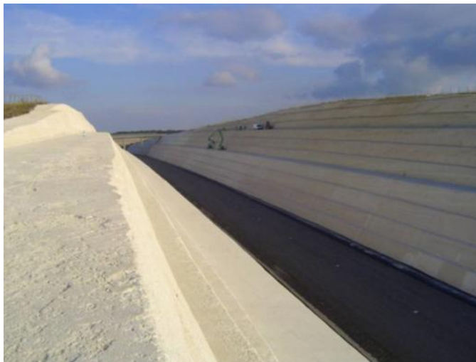
Illustration - Traitement des parements par émulsion de silicate
