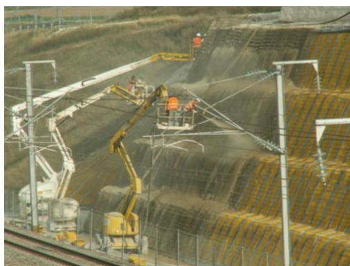
Première couche de béton projeté (vue de 3 ateliers)
