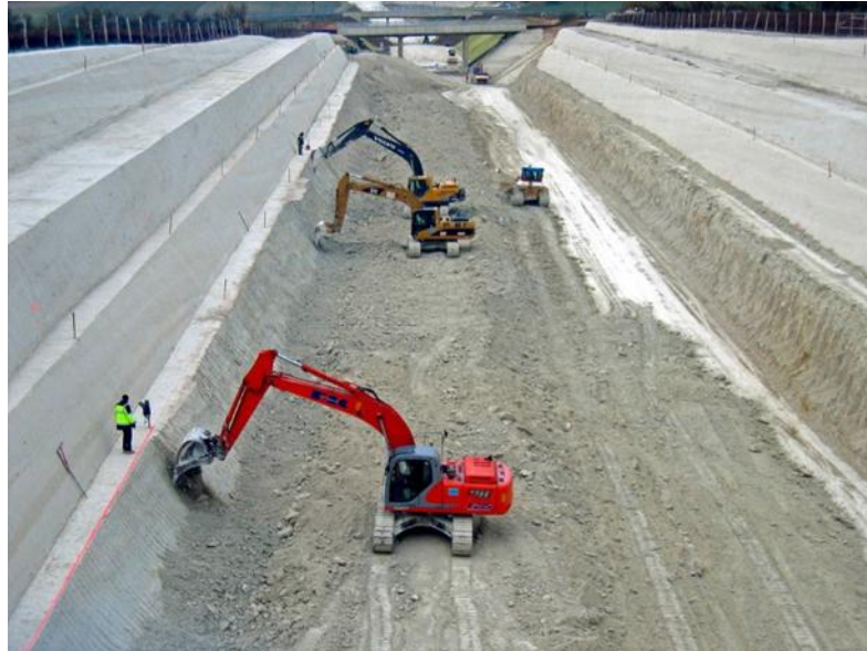
Illustration - Réglage fin des talus
