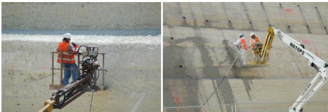
Illustrations – « Béton projeté » : Forage des ancrages (détail) / Injection des ancrages
