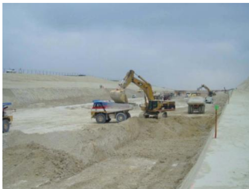
Déblai grande masse par passes de 3m
