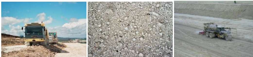
Illustrations (de gauche à droite) : Malaxage du matériau traité / Matériau après malaxage (mouture de 0/70 après 3 passes) / Arroseuse TERRA-GATOR (avec enfouisseurs)
